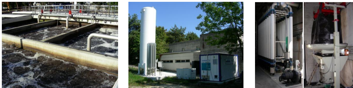
Figure 2 : à gauche : bassins du lit fluidisé ; au milieu citerne d’oxygène avec le container du générateur d’ozone ; à droite membranes d’ultrafiltration pour la séparation du CAP et « big bag » de CAP.
